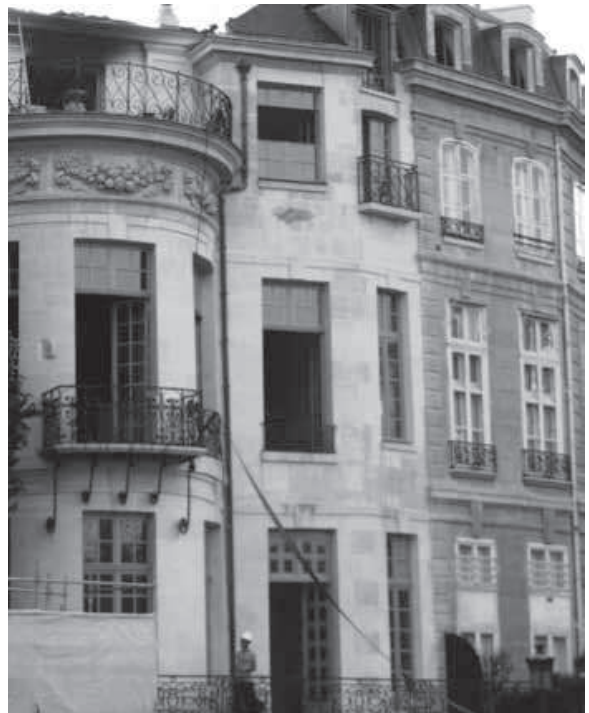
Widać brak dachu, spaloną górną kondygnację i otwarte okno Galerii Herkulesa.
